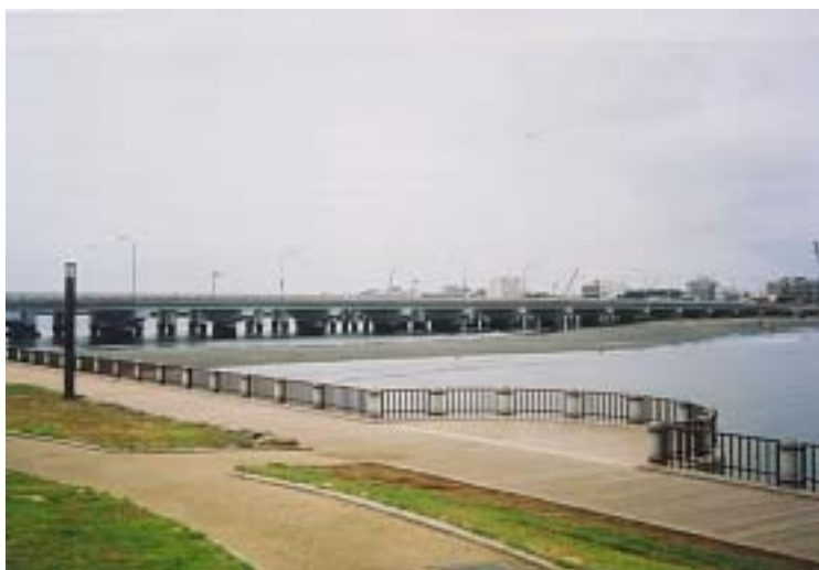
耐震補強された江の島大橋（湘南港）
