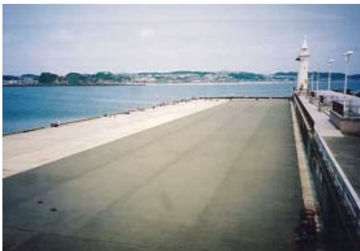
耐震化されている本船岸壁（湘南港）
